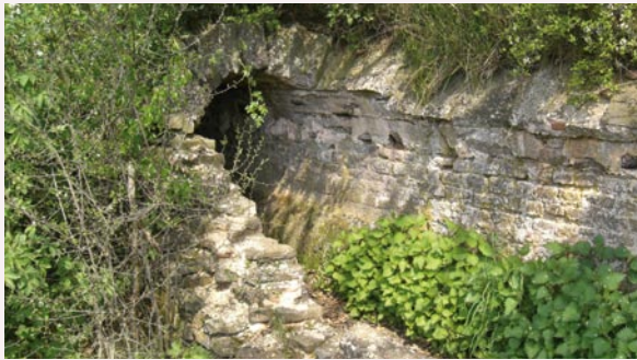
Kanalaufschluss in Mechernich-Breitenbenden
