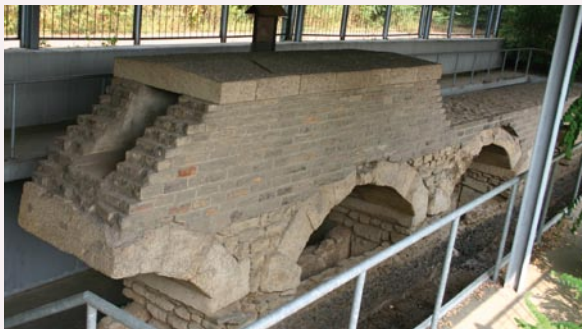
Kanalaufstockung in Hürth
